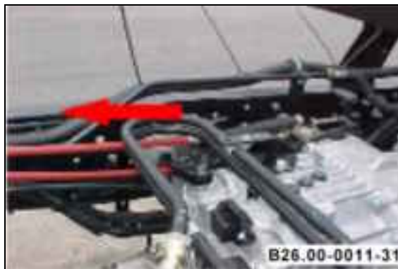
Cables sobre la caja de cambios B26.00-0011-31
