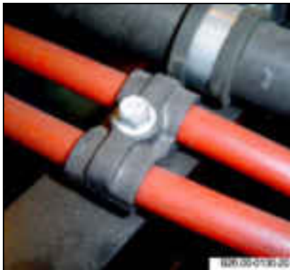
Fijación de los cables B26.00-0130-20
