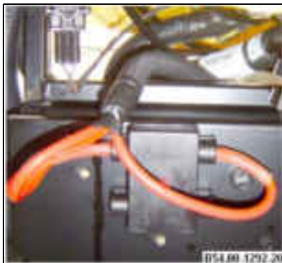
Detalle de la caja del fusible general B54.00-1292-20
