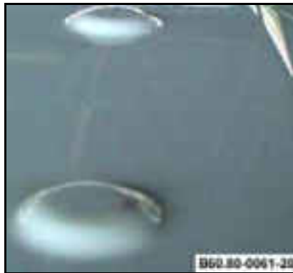
Saliências do teto da cabine
